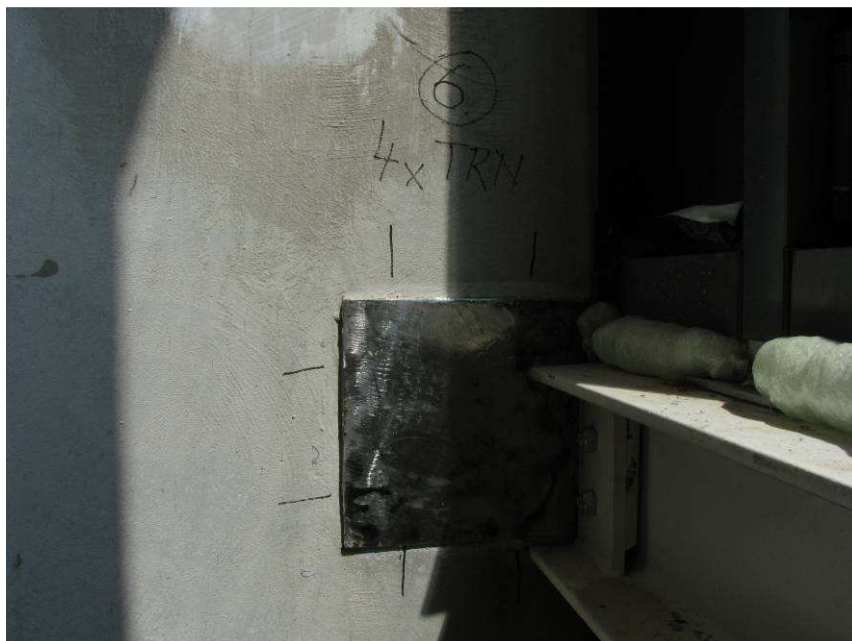
Obr. 23.: Pohled na dodatečně montovanou desku technologického spoje.
