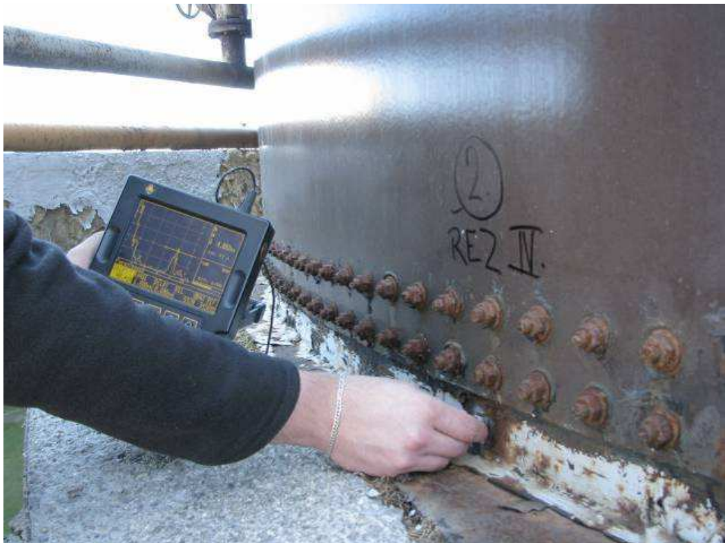
Obr. 2.: Provádění UZ kontroly tloušťky patního plechu pomocí přístroje SONIC 1200HR.
