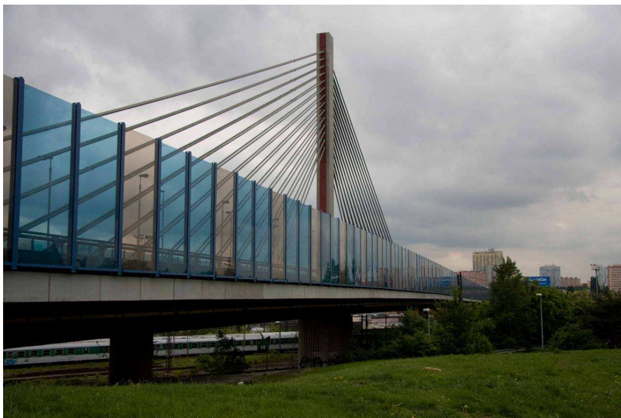
Obr. 1.: Celkový pohled na most
