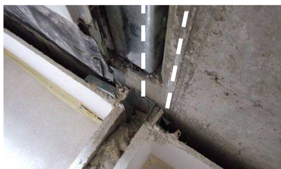
Obr. 7.: „C“ profil prochází připojovací spárou okna
