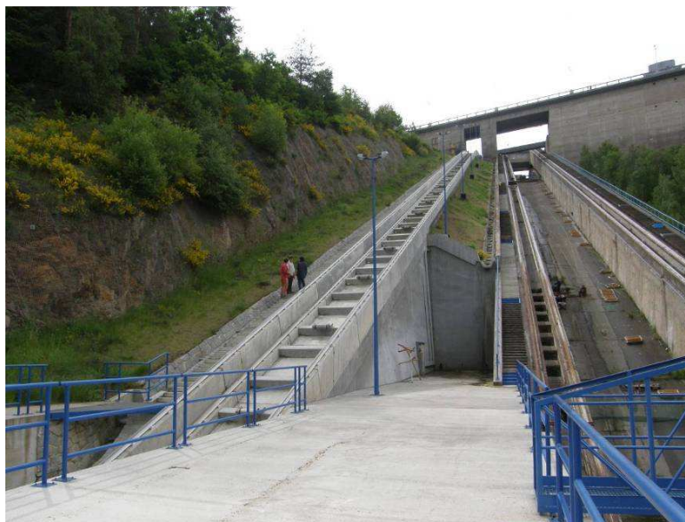
Obr. 5.: Celkový pohled na výtah sportovní plavby vodního díla Orlík.
