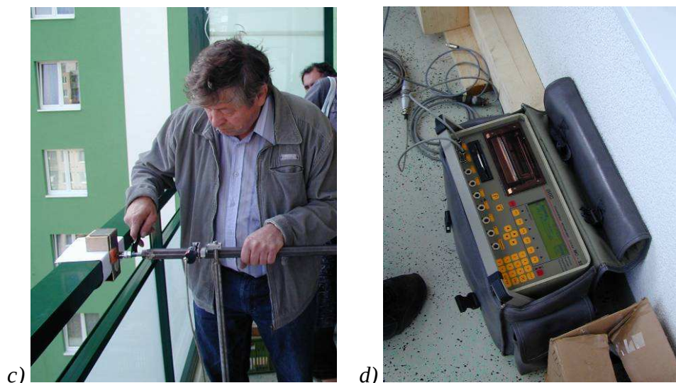
Obr. 13: Realizace zkoušek pro porovnání tuhosti kovového zábradlí balkonů
