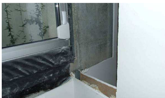
Obr. 6.: Rozkrytí připojovací spáry okna v obývacím pokoji
