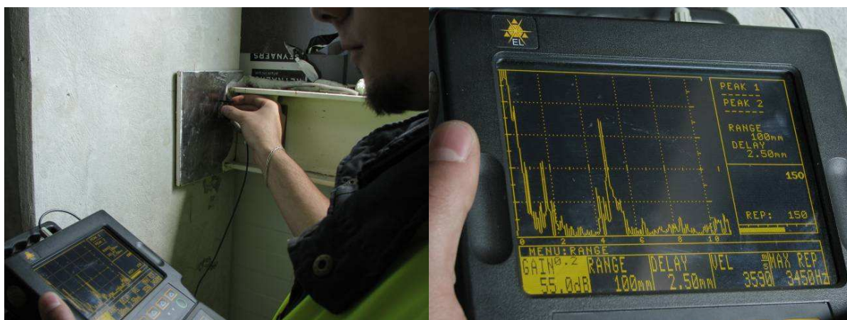
Obr. 24.: Průběh testů kotevních trnů na dodatečně montovaném technologickém spoji spolu s ukázkou echa nálezu.
