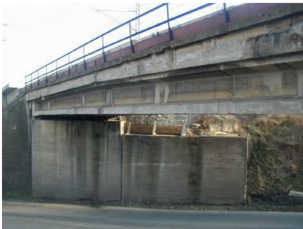
Obr. 1.: Pohled na levou stranu mostu
