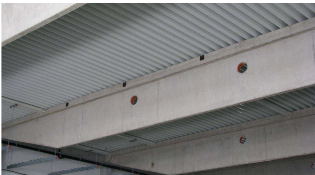
Obr. 18.: Pohled na zabudovaný nosník s kotevními deskami.
