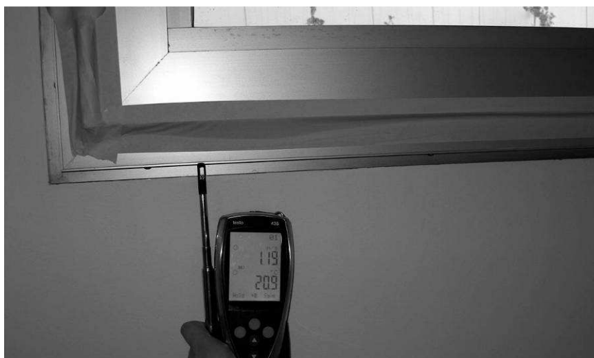
Obr. 2.: Měření rychlosti proudění vzduchu anemometrem při udržovaném podtlaku v interiéru, horní hodnota je rychlost proudění v m/s, dolní hodnota je teplota vzduchu v °C
