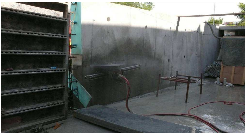
Obr. 2.: Řezání betonové konstrukce
