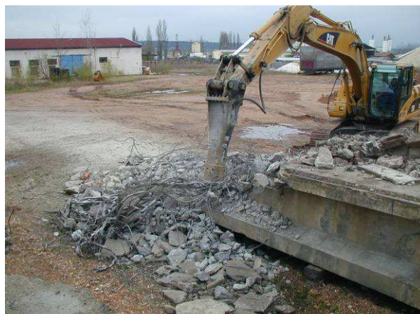
Obr. 6.: Demolice pravého nosníku
