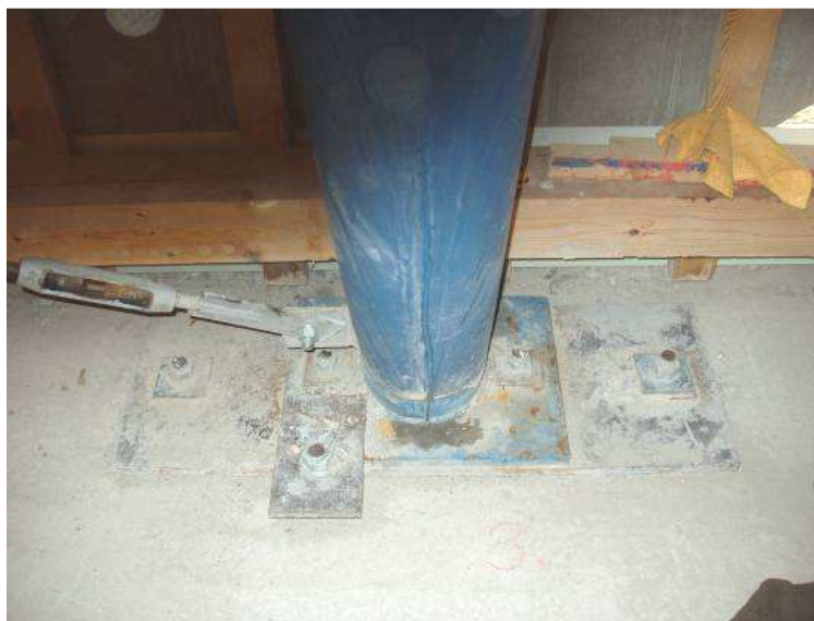
Obr. 7.: Pohled na ukotvení ocelového sloupu.
