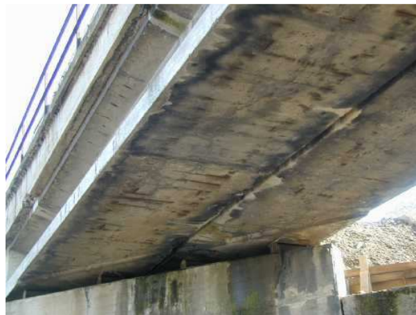
Obr. 2.: Pohled na spodní líc nosné konstrukce
