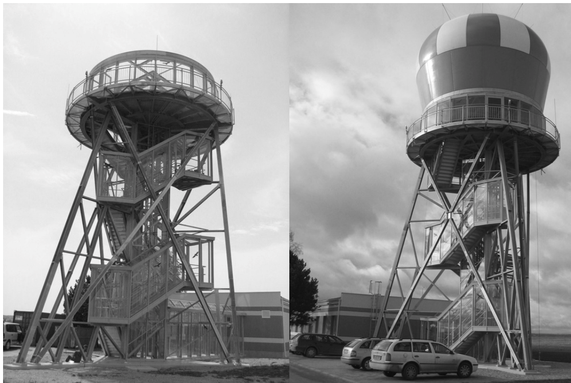
Obr. 9.: Nová věž radaru před a po dokončení s osazenými výztuhami ve tvaru X
