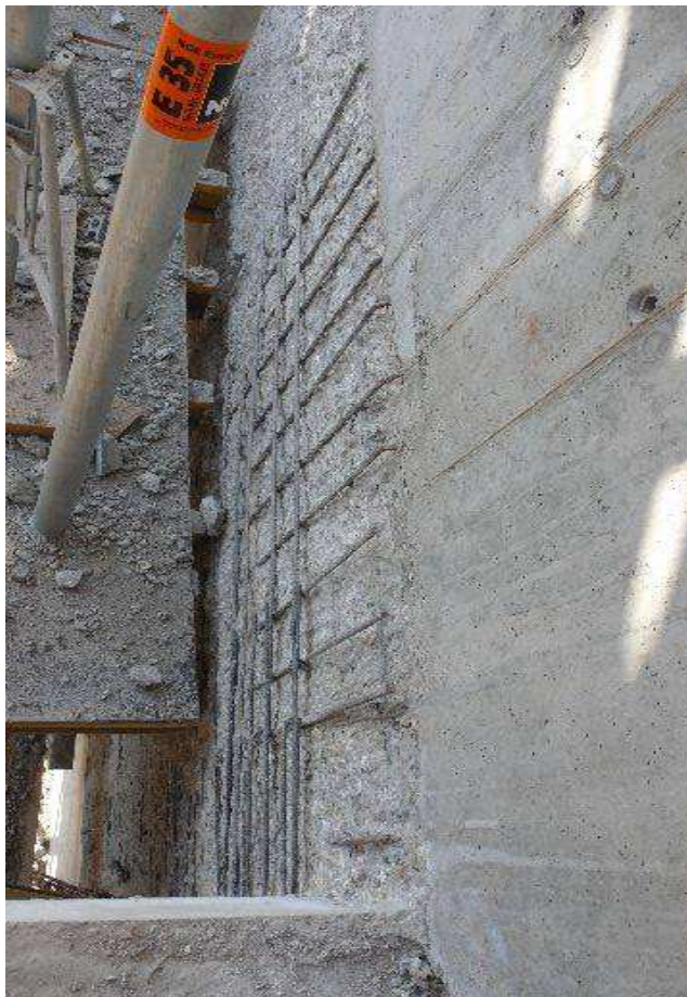
Obr. 3.: Obnažená výztuž po ubourání vychýlené části konstrukce
