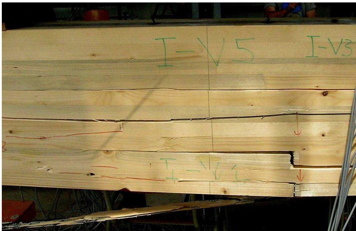
Obr. 11.: Charakteristický náhly lom nosníka s odtrhnutím a následným odšmyknutím výstužného pásu
