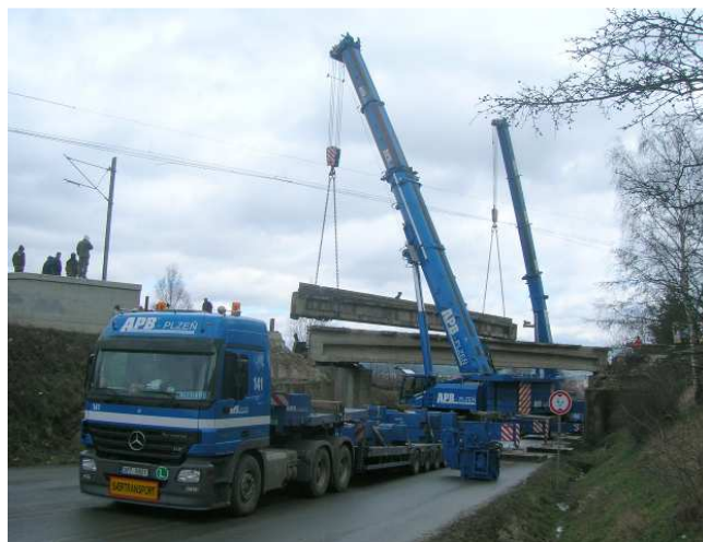
Obr. 4.: Snášení nosníku na podvalník
